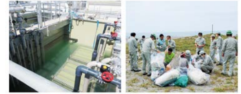
排水処理設備の設置工事
