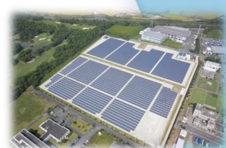
メガソーラー発電所 静岡県磐田市
